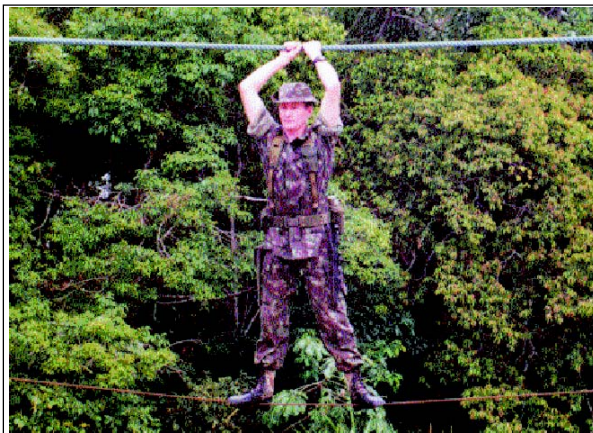
Fig 4-13. Ponte de 2(duas) cordas (falsa baiana)
