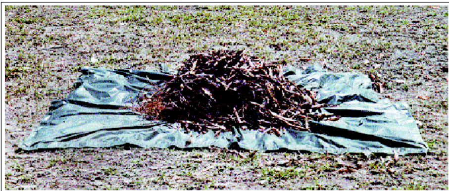
Fig 4-29. Folhas cortadas para enchimento da bóia
