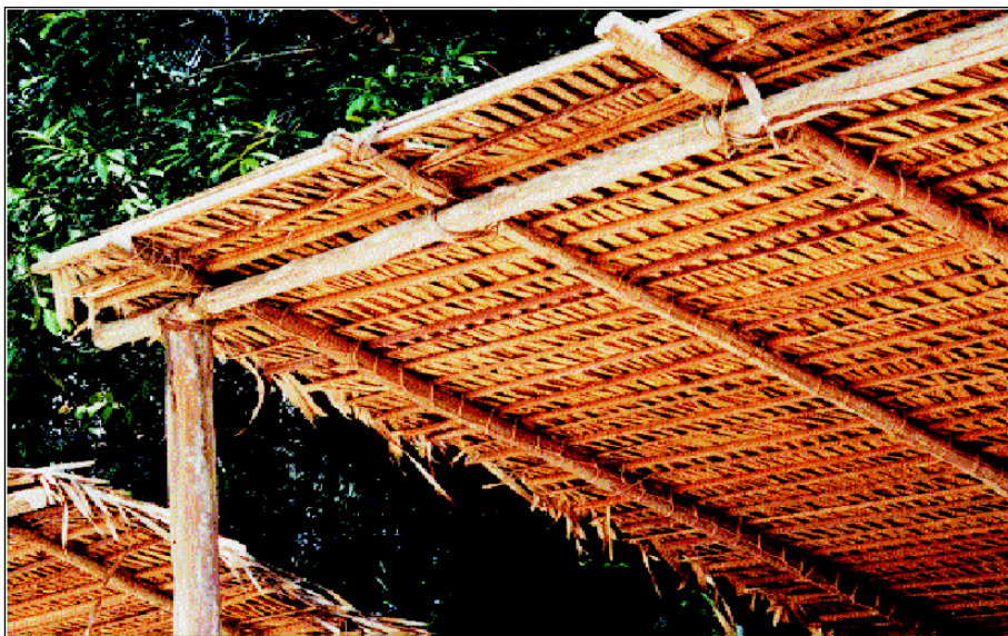
Fig 5-23. Tapiri simples de moradia: detalhe da cobertura
