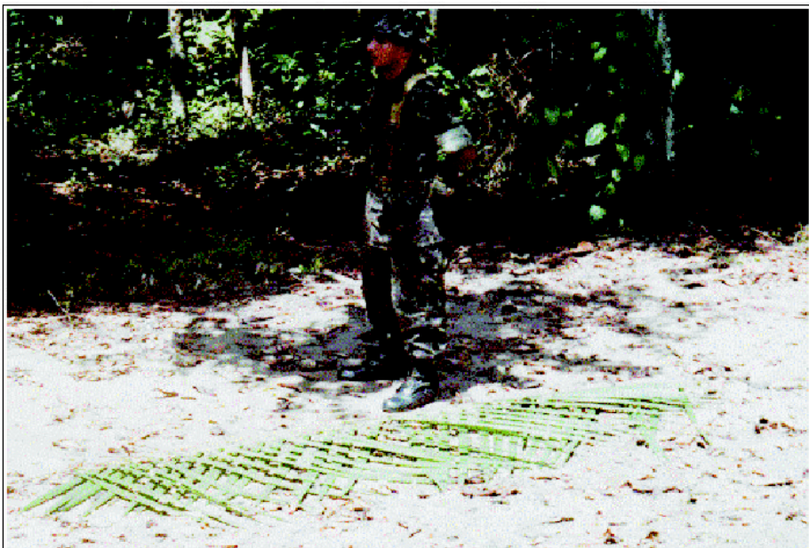
Fig 5-22. Uma palha pronta para cobrir o telhado
